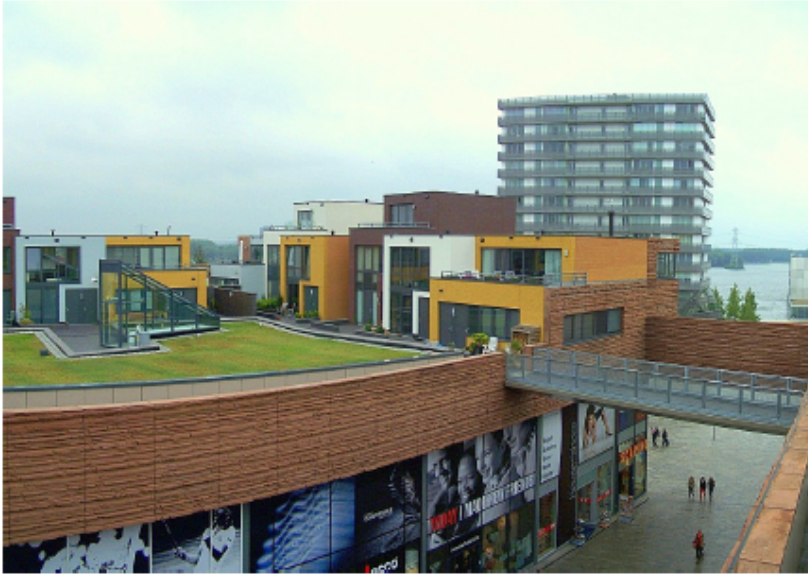
stadsappartementen op dak supermarkt
