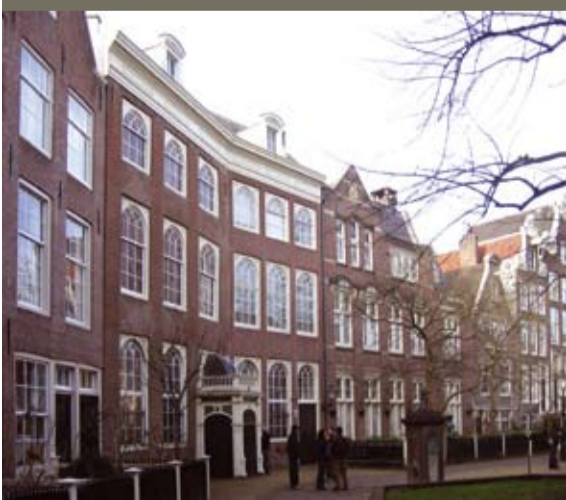
restauratie Begijnhofkapel, Amsterdam, 1929
