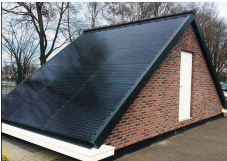
Een systeem van waterdichte panelen die dakpannen vervangen en waarmee daken kunnen worden bedekt: het Hengelose aannemersbedrijf Droste ontwikkelde het en won daarmee de derde prijs.
