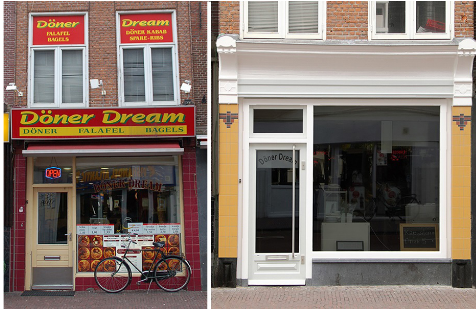
Afb. 25, Cafetaria voor restauratie (Herstelde gevels van Leiden, sd) , 2014) Afb. 26, Sfeer weer terug in de straat (Herstelde gevels van Leiden sd, 2014)
