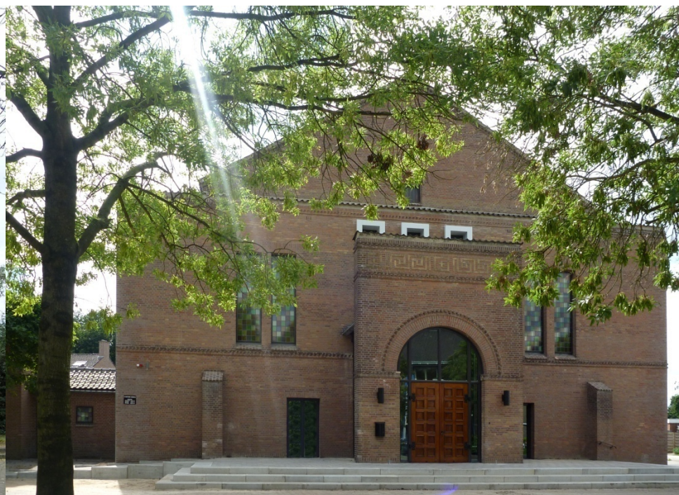
Na de verbouwing
