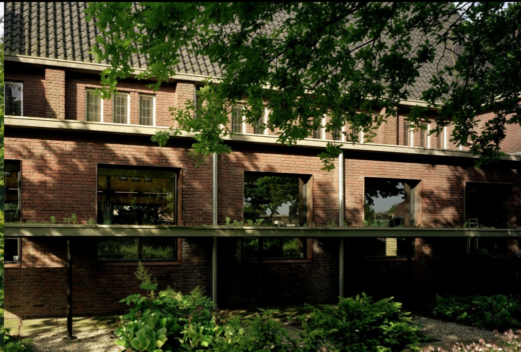
Nieuwe glasopeningen aanbrengen
