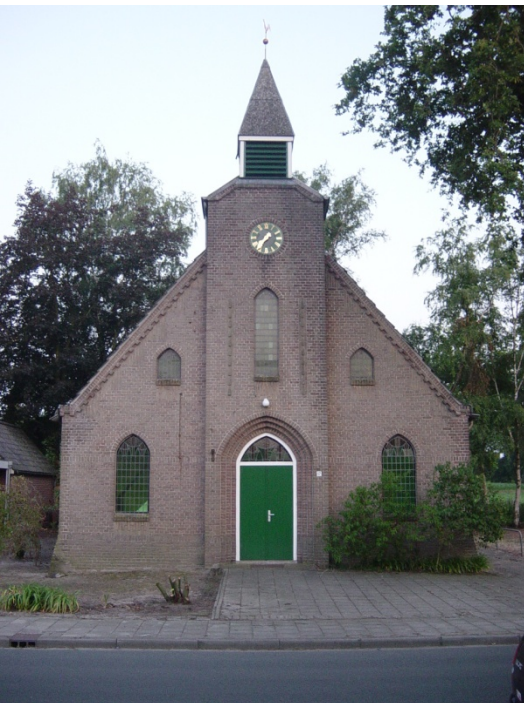
Exterieur voor de verbouwing
