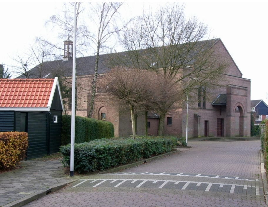
Exterieur voor de verbouwing
